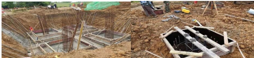
塔基基础大开挖施工
