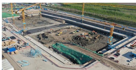
(a) 基坑开挖后实景
