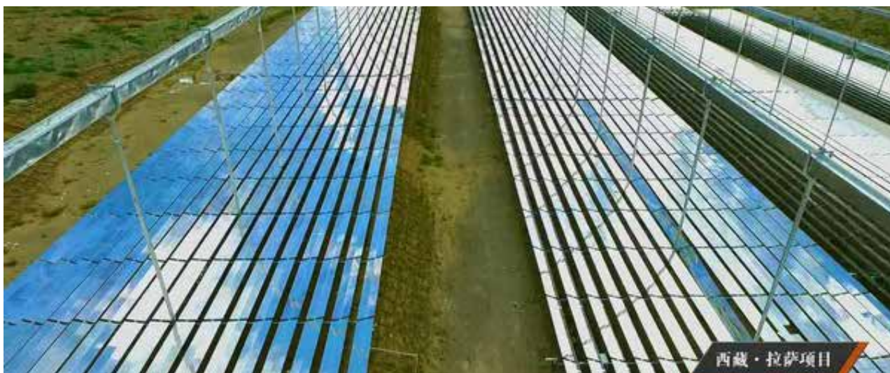
图：拉萨市柳梧新区 1MWe 线菲式太阳能热电联供能源站 (图片来源：兰州大成)
