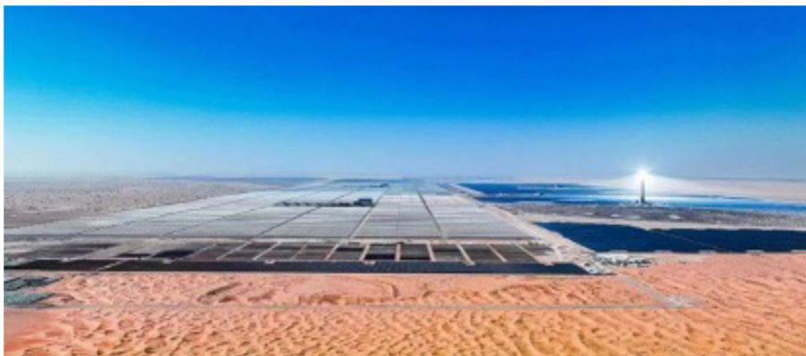
图 2.2-1 NOOR ENERGY 1 太阳能混合项目（图片来源：上海电气）
