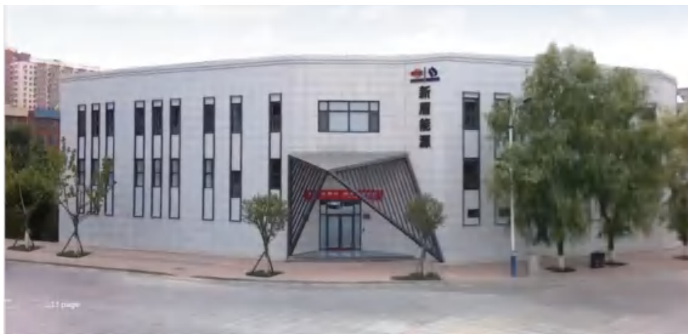
图3 已建成1号能源站外观
