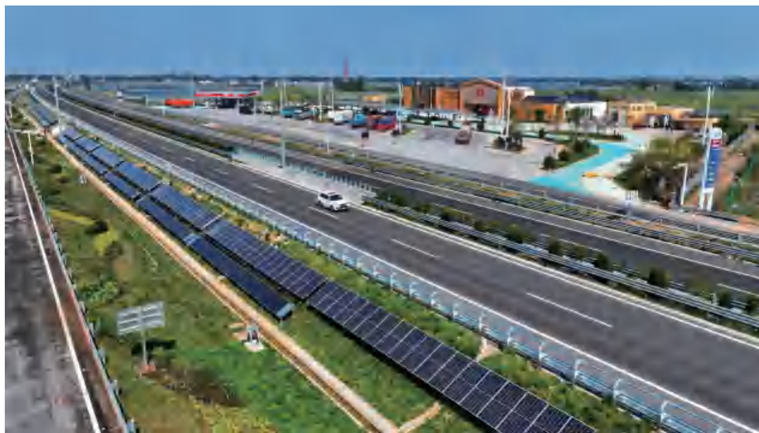
图 2 长线型边坡光伏
