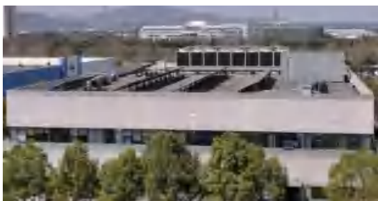
图 3 办公楼屋顶光伏
