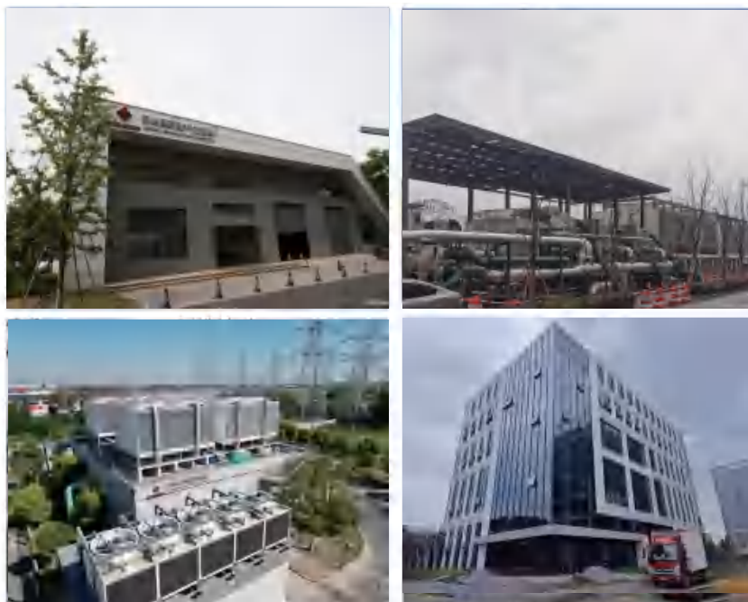
图5 杭州医药港多能互补区域集中供能项目已建成4座站点
