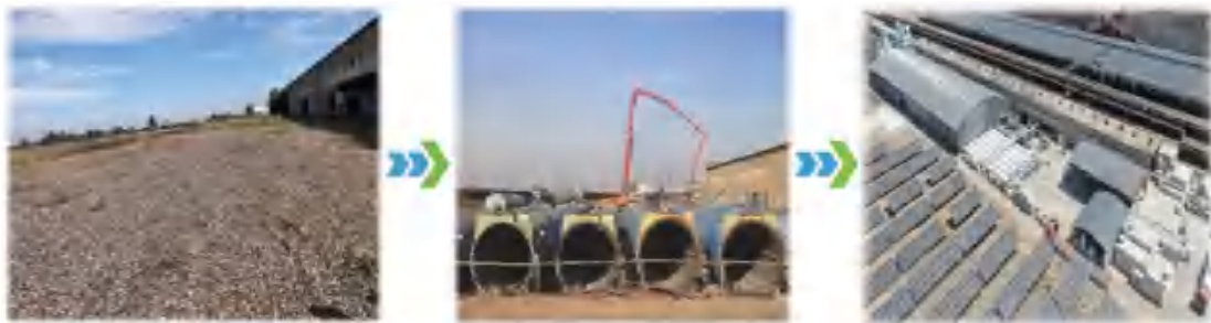
图3 加气砖厂建设过程
