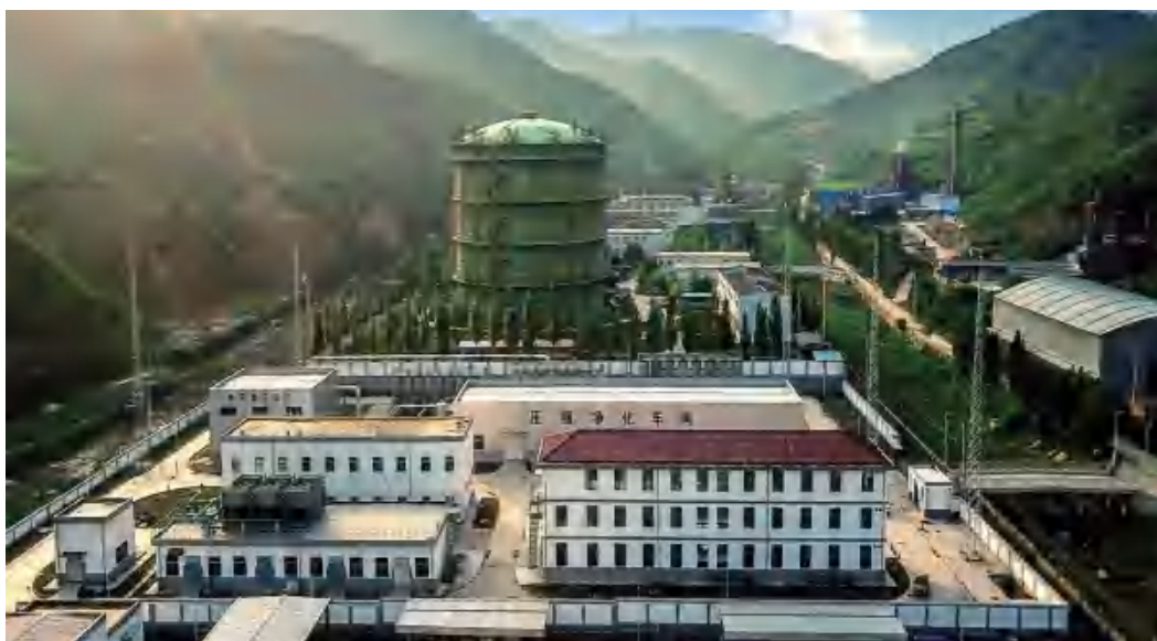
图 2 低浓度煤层气高效利用制 CNG 工业示范项目
