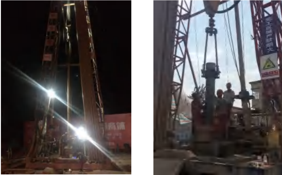
图 5 地热井钻探施工
