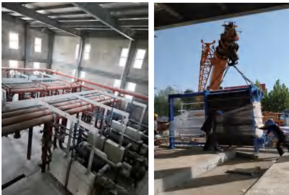
图 8 能源站设备安装
