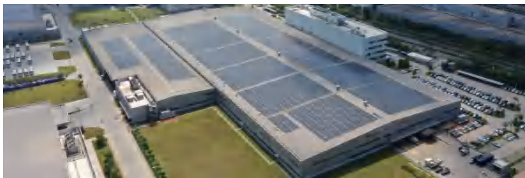
图 2 厦门 ABB 工业中心厂房屋面俯视图
