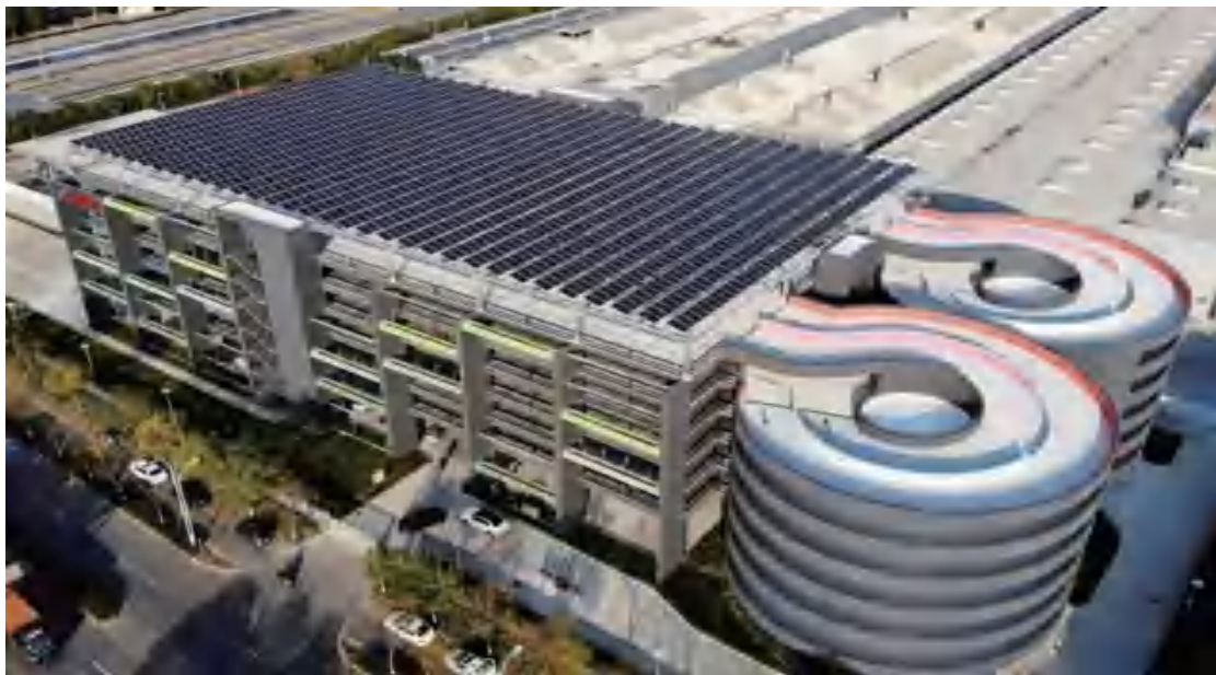
图 1 园区某企业屋顶光伏
