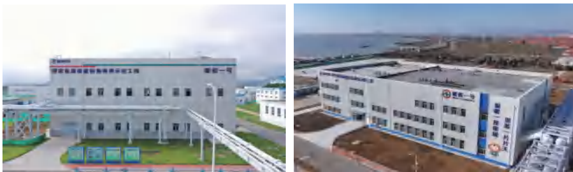
图 3 “暖核一号”核能供暖工程二期、三期供热首站
