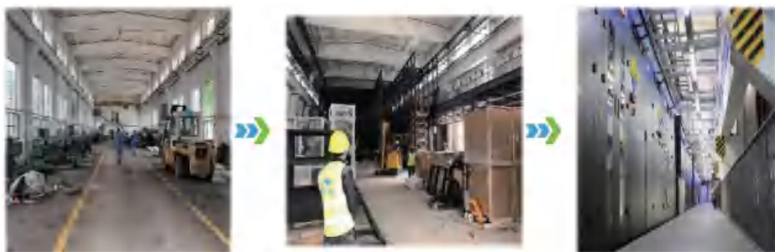
图5 数据中心建设过程
