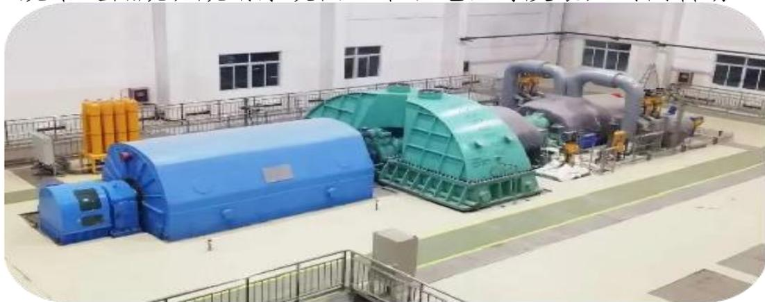
图 3100MW 超高温亚临界煤气发电
