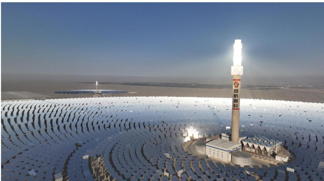
熔盐塔式光热示范电站主要由聚光系统、吸热系统、储换热系统及发电系统等部分组成。
