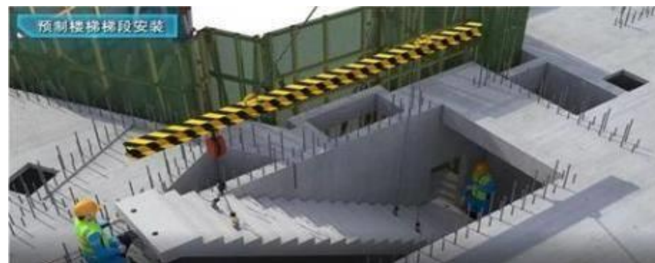
图 40：预制楼梯安装模拟
