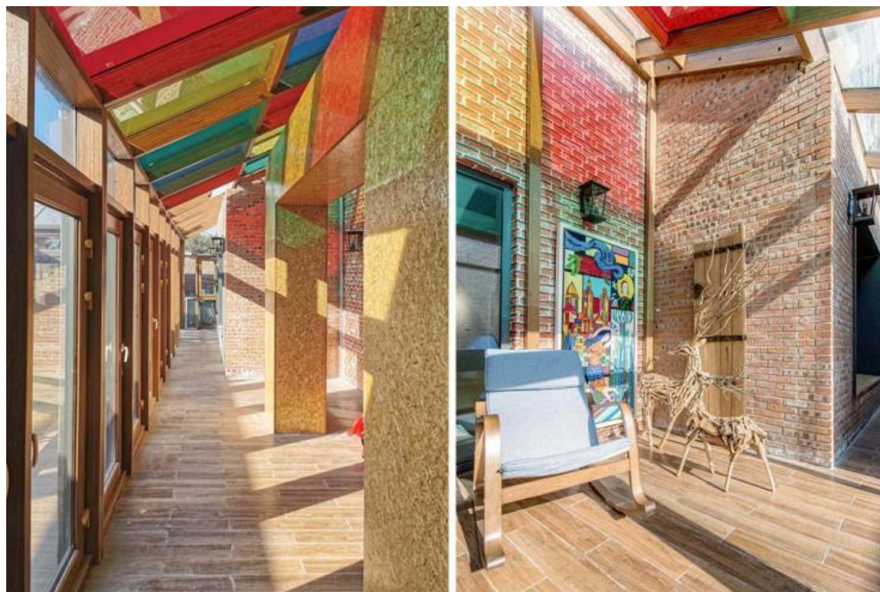
图 18：阳光透过彩色薄膜光伏顶落在阳光房的墙面上
