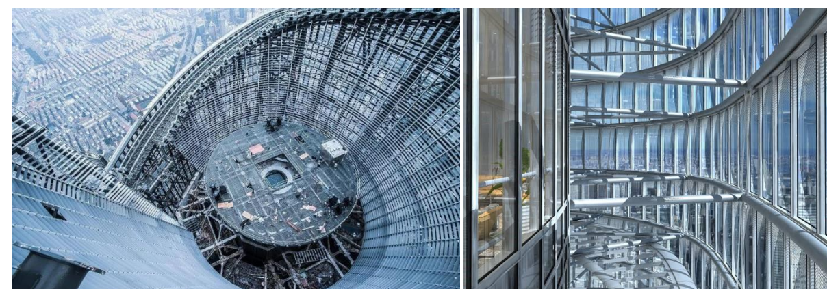
图 7：上海中心大厦的双层玻璃幕墙系统
